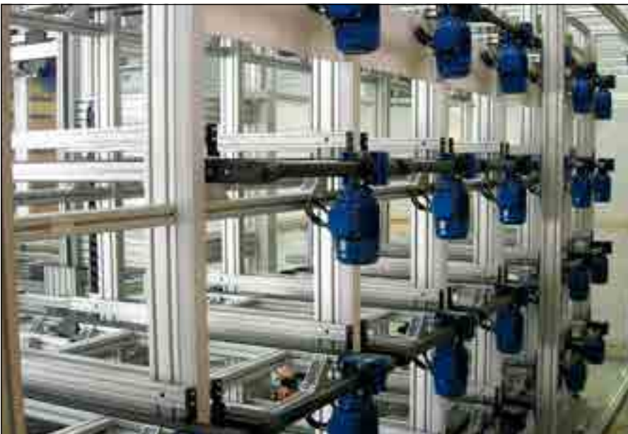
Doppelgurtförderer in vollautomatischem Hochregallager
