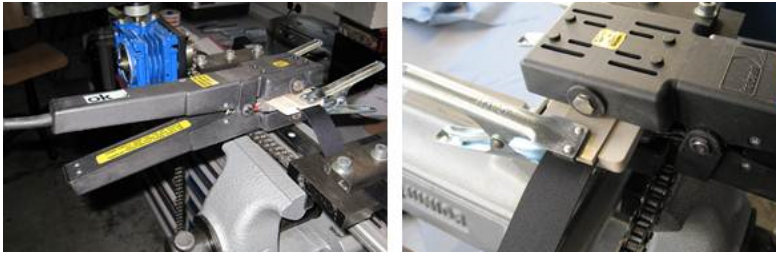
Abbildung 9: Verschweißen der Z-Verbindung mit Heizzange (Art.-Nr.: H080691270)
